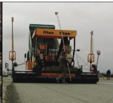
Aanleg van vliegvelden
